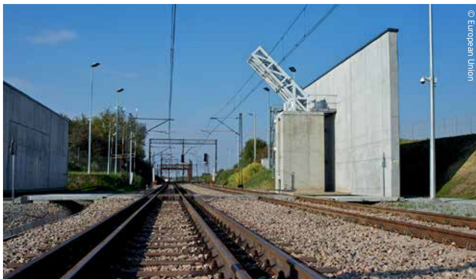
Vérification de wagons sur des voies ferrées: un scanner de train à la frontière entre l'Ukraine et la Pologne.
