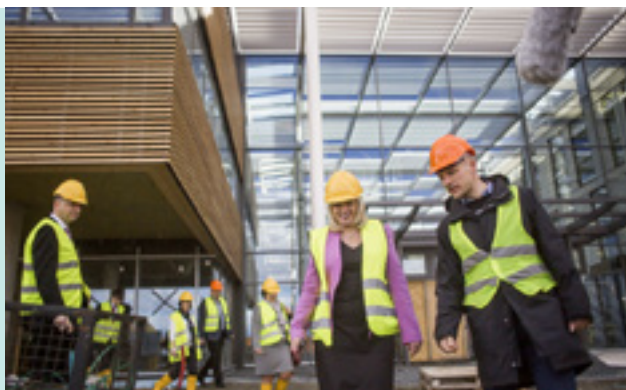
Komissaari Corina Crețu rakennustyömaalla Prahassa Tšekissä 31. maaliskuuta 2015.
